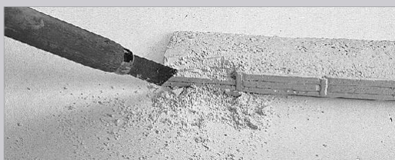
Abschaben einer Schwelle am Schüttbahnsteig 2158.
