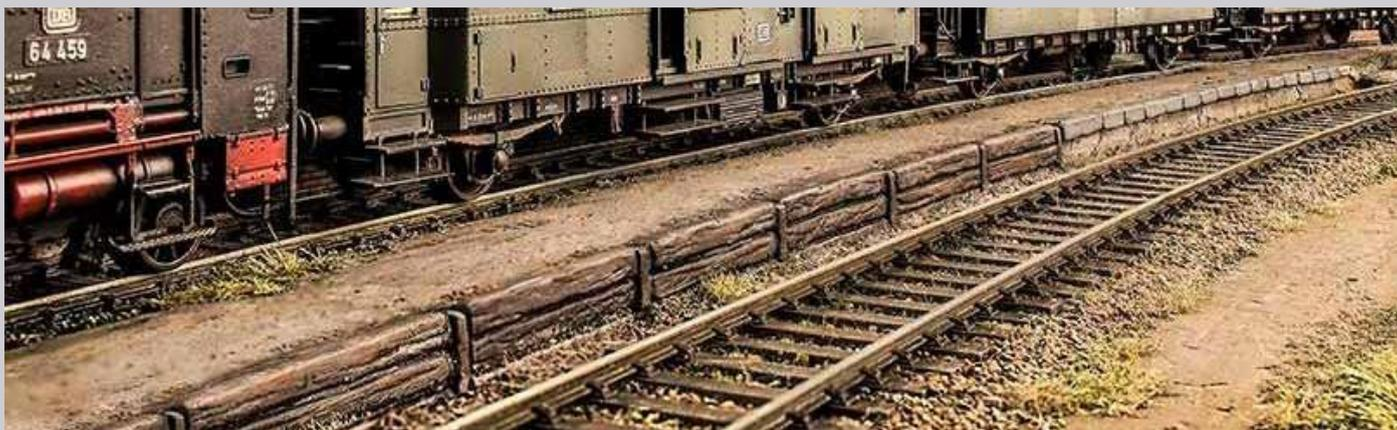
Abb.: SCHÜTTBAHNSTEIG 2158 mit Schwellen, hinten mit Steinkante. 2159.
